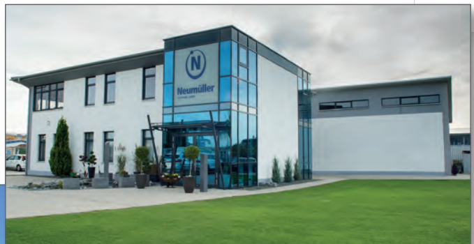
Zentrale in Weisendorf bei Nürnberg
